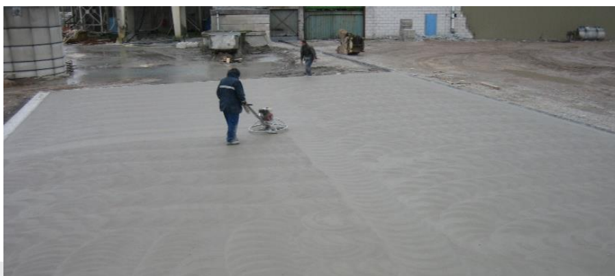
Foto: Voorbeeld van een vlakke vloerafwerking.
