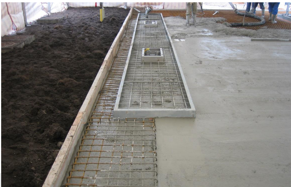
Foto: Aanbrengen van een betonverharding.
