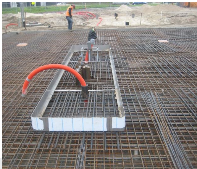
Foto: Voorbeeld in te storten onderdelen/wapening.
